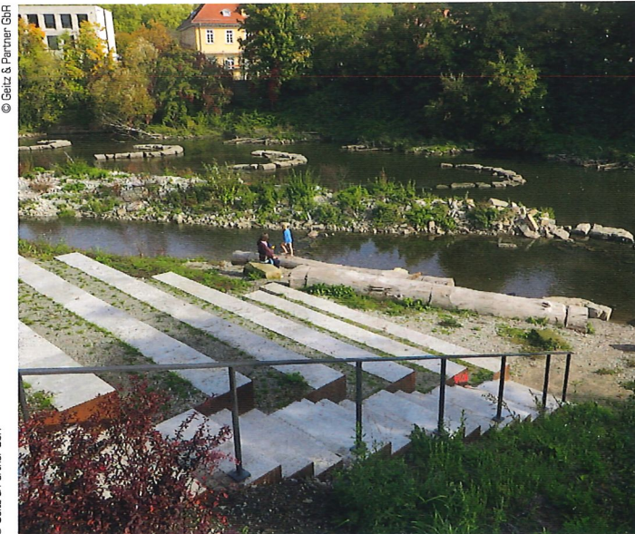
Eine großzügige Sitzstufenanlage führt zum neuen Seitenarm mit flachem Kiesufer und Sitzstämmen. In das Bestandsbett des Kochers wurden zahlreiche Strukturen aus Totholz und Steinen eingebaut, um eine gewässerökologische Aufwertung zu erzielen.
