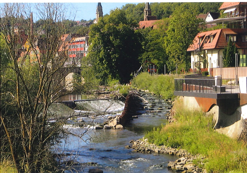
Die Fischtreppe verbindet das Oberwasser des Dreimühlenwehres mit dem Unterwasser. Die bestehende, im Bestand teils sehr unansehnliche Ufermauer wurde mit einer wellenartig geschwungenen Stahlverkleidung optisch aufgewertet und spiegelt so die Bewegung des Wassers in den angrenzenden Freiraum.
