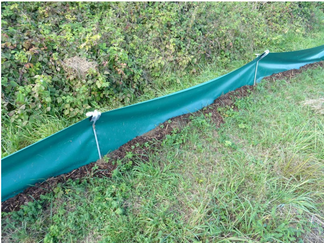
Foto 4: Reptilienzaun zur Verhinderung der Einwanderung von Reptilien ins Plangebiet (04.10.2023)
