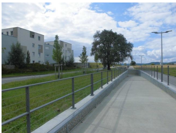
Foto 5: Südlich angrenzende Wohnbebauung mit Unterführung
