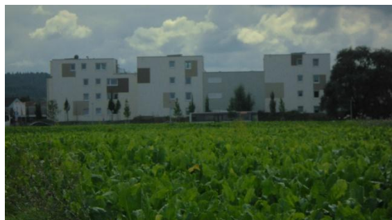
Foto 4: Südlich angrenzende Wohnbebauung von Norden
