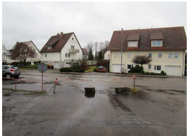
Abb. 8: Blick Richtung Süden auf die Haller Straße im Bereich des künftigen Anschlusses
