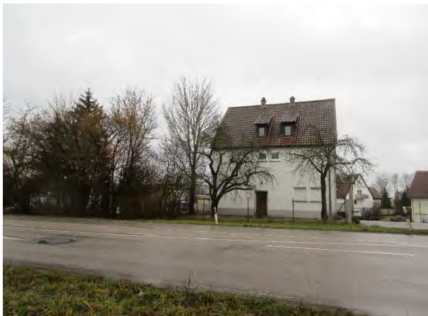
Abb. 7: Blick Richtung Süden auf das abzureißende Gebäude mit zu fällendem Baumbestand.
