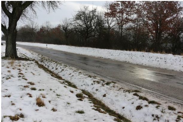
3) Blick auf K 2602 mit Entwässerungsgraben © Klärle GmbH, 16.02.2021
