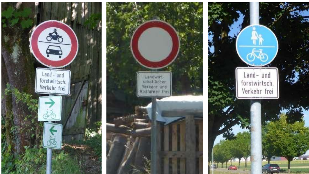
Abbildung 69: unterschiedliche Beschilderungen für die Führung des Radverkehrs gemeinsam mit dem land- und forstwirtschaftlichen Verkehr
