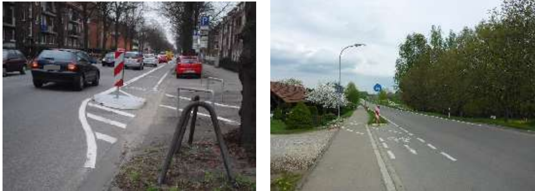
Abbildung 97: Beispiele für verschiedene Überleitungen des Radverkehrs
