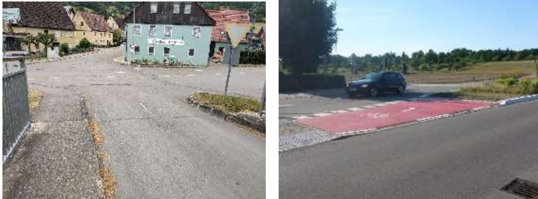
Abbildung 70: fehlende Querungshilfe Knotenpunkt Weinbrennerstraße / Gaisdorfer Straße / Mühlweg in Haagen (links), vorhandene Überleitung im Gewerbegebiet Kerz (rechts)
