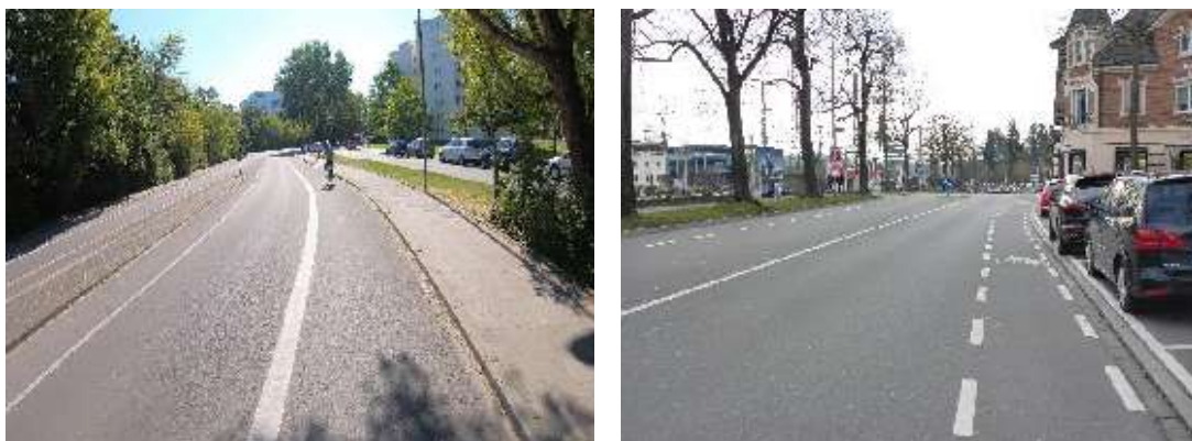
Abbildung 91: Beispiele für gemeinsame Führung von Kfz- und Radverkehr (Radfahrstreifen links / Schutzstreifen rechts)
