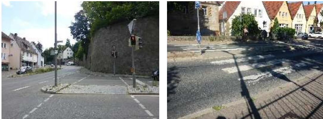
Abbildung 81: eingeschränkte Barrierefreiheit an Querungsstellen (links Zwinger, rechts Langer Graben)
