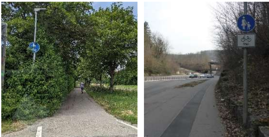
Abbildung 68: Gemeinsamer Geh-/Radweg entlang Breiteichstraße (links), Gehweg „Rad frei“ entlang der Stuttgarter Straße (rechts)
