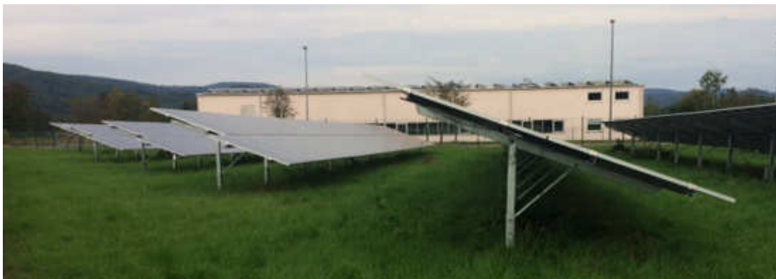
Bodenschonende Aufstellung der Module; die Pfosten werden eingerammt, keine Grabarbeiten erforderlich
