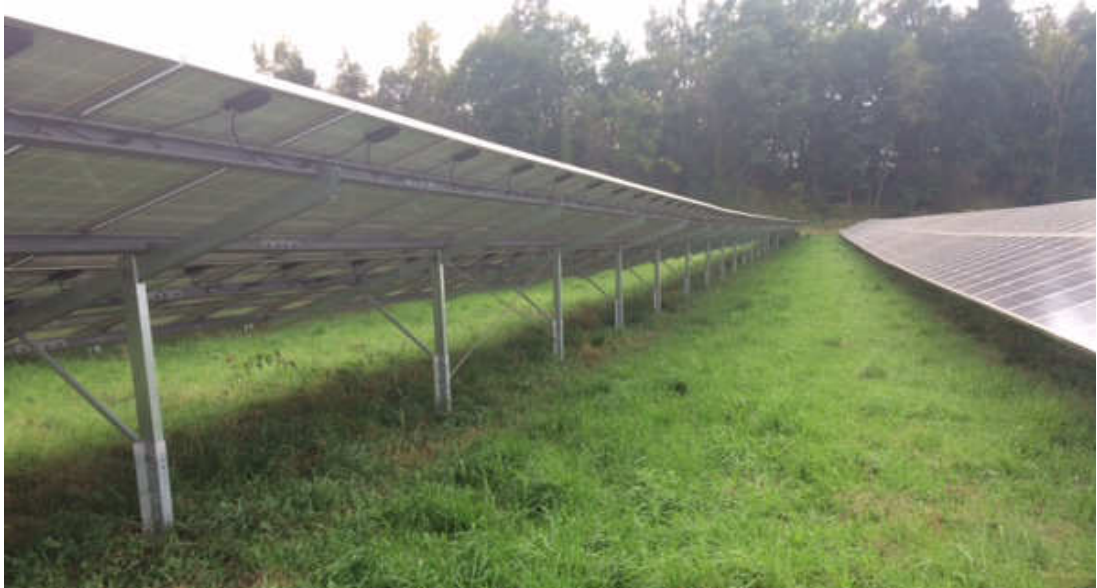
Bodenschonend aufgestellte Fotovoltaik Elemente
