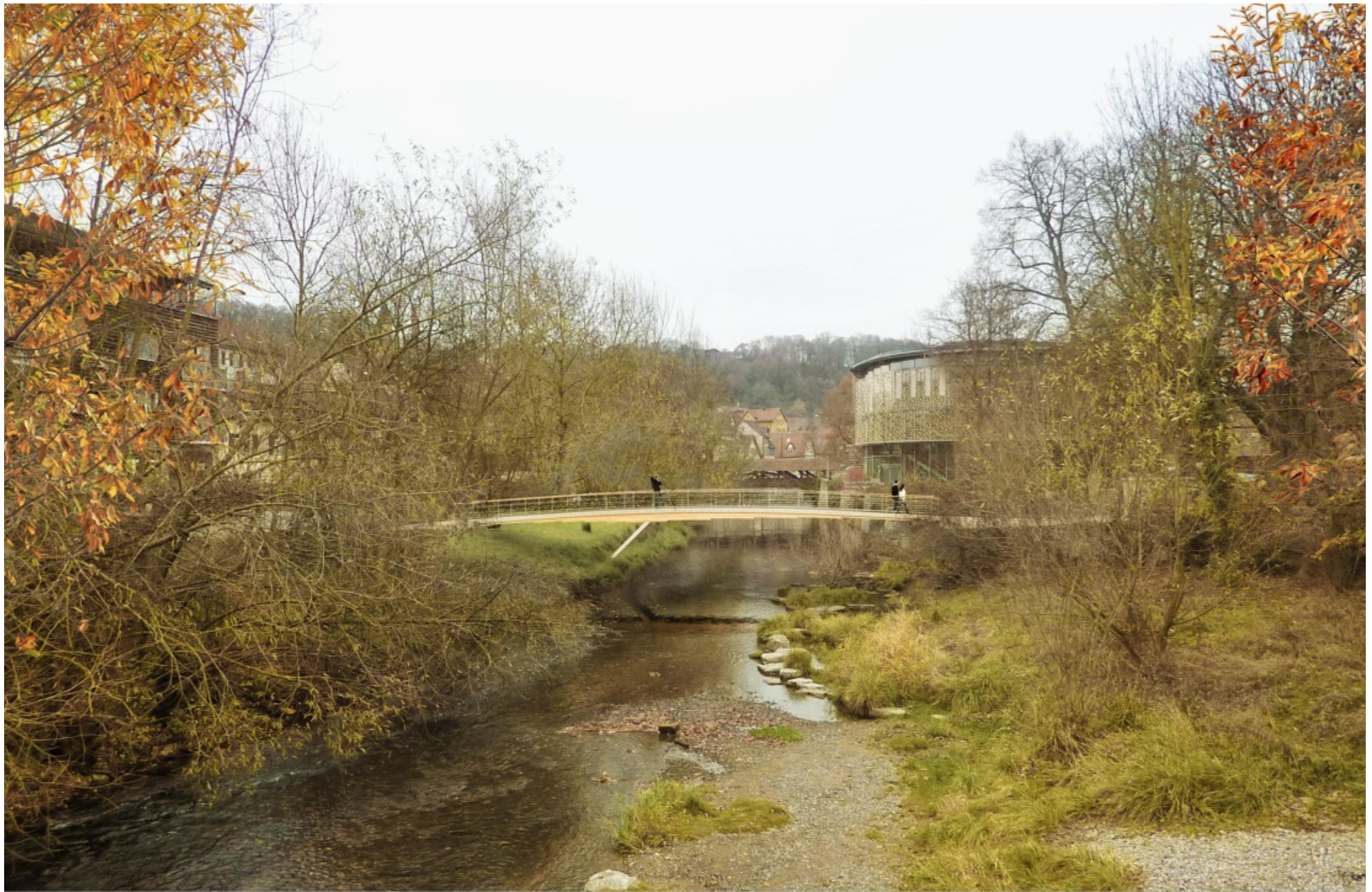
Neubau Lindachbrücke am Großen Unterwöhrd / Im Lindach in Schwäbisch Hall
