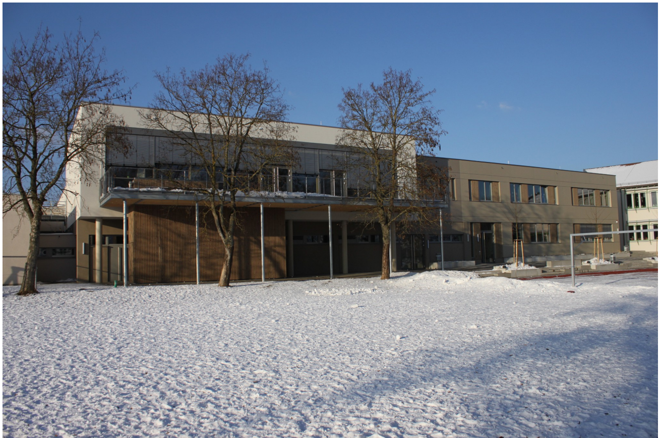
Breit-Eich-Grundschule mit Turnhalle
