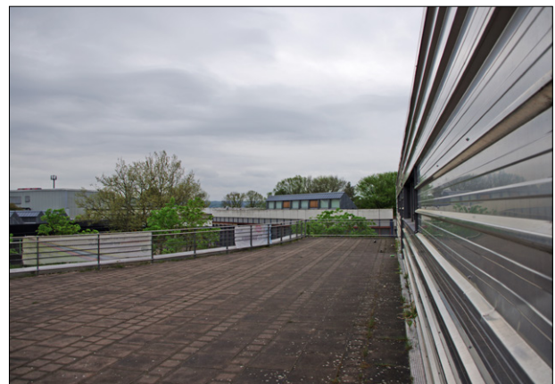
Dachterrasse über der Mensa
