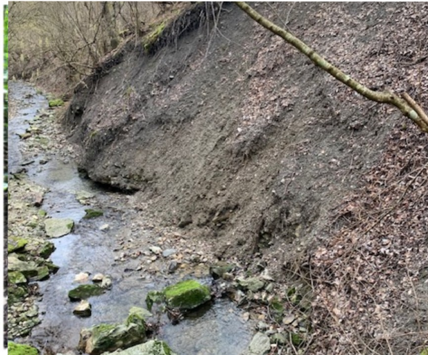
Bild 18: ungesicherte Böschung nach Auslauf
