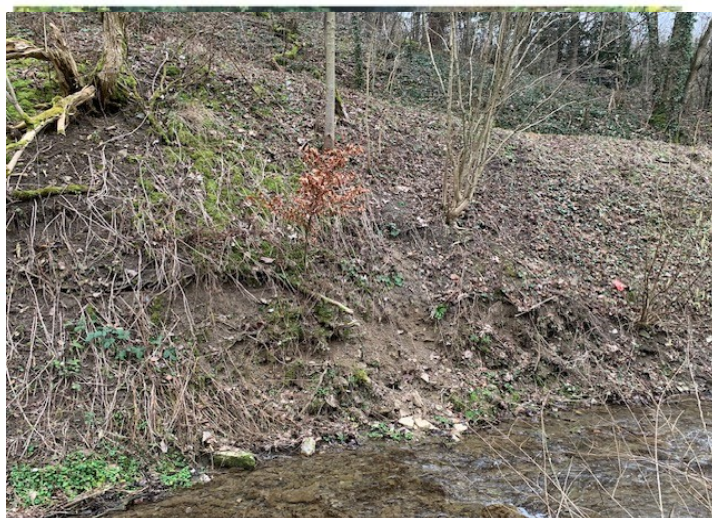
Bild 7: Best. Böschungsfuß unterhalb Ödenbühlsteige
