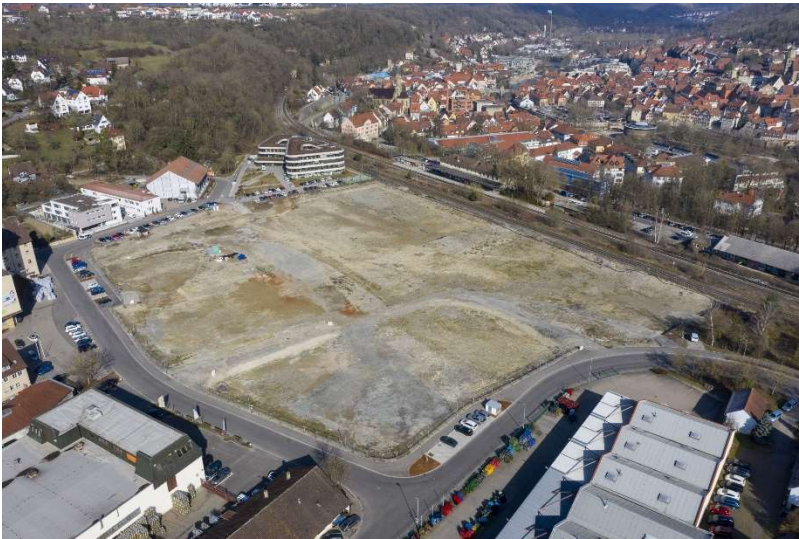
Bahnhofsbereich Schwäbisch Hall
