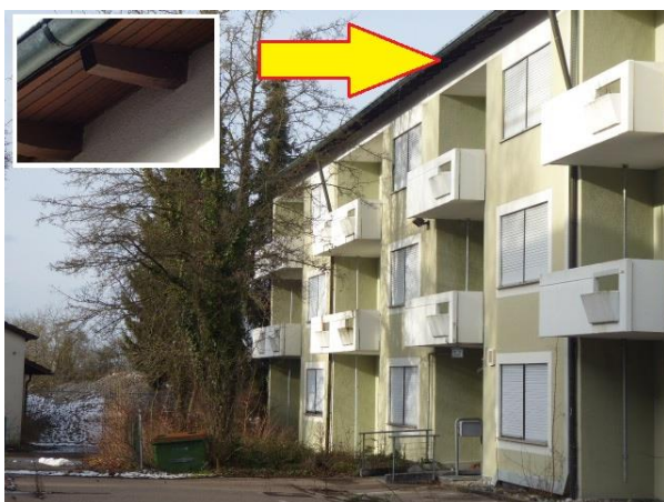
Abb. 5: Westseite des ehemaligen Polizeireviers mit Dachüberstand.
