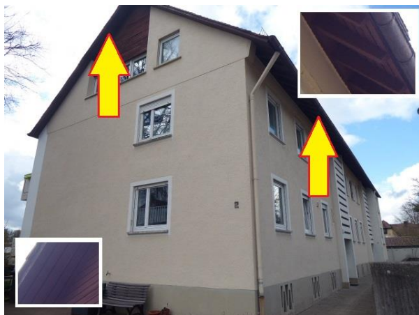
Abb. 3: Nord- und Westseite von Mehrfamilienhaus Gräterweg Nr. 2 mit Dachüberständen.
