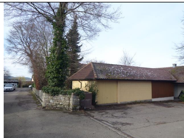
Abb. 8: Nebengebäude des Anwesens direkt am Gräterweg mit Dachüberstand.
