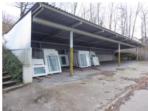
Abb. 16: Überdachter Abstellschuppen zwischen den beiden ehemaligen polizeilich genutzten Gebäuden ohne Reste von Nestern.
