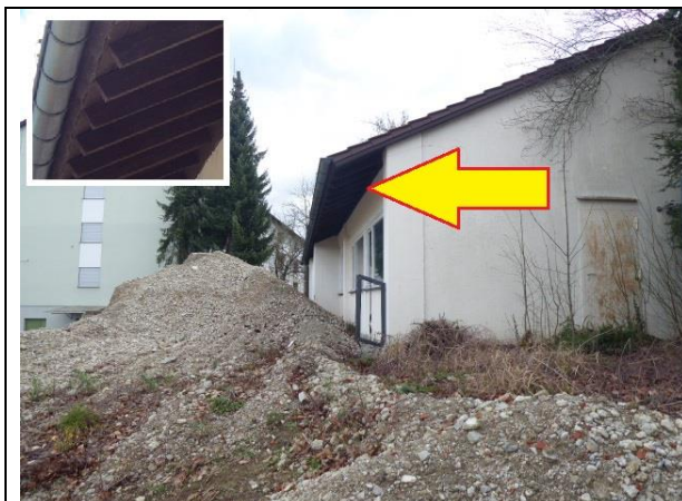
Abb. 7: Rückwärtiger Teil des Gebäudes Gräterweg 10 mit Dachüberstand.
