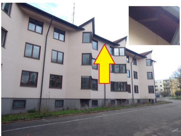
Abb. 15: Dachüberstand am der südöstlichen Traufseite des Gebäudes Im Lehen Nr. 1 und 1/1 ohne Nestbaumöglichkeit.
