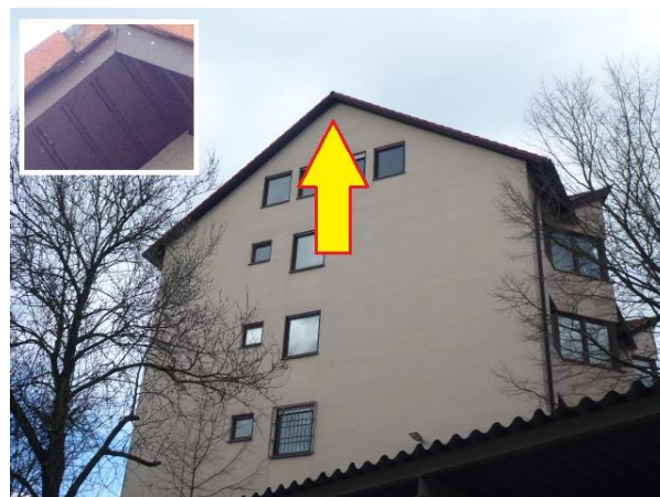
Abb. 14: Dachüberstand am der Giebelseite des ehemaligen Quartiers der Kriminalpolizei in SHA.
