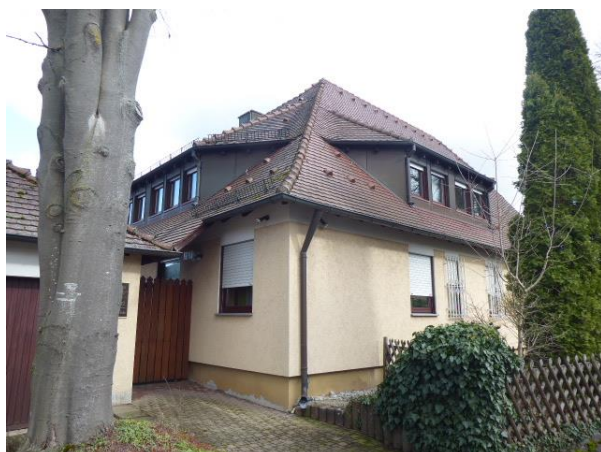
Abb. 11: Dachvorsprung des Gebäudes Gräterweg 12/1 ohne Nistgelegenheiten für Vögel.
