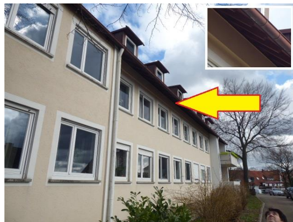
Abb. 4: Ostseite von Mehrfamilienhaus Gräterweg Nr. 2 mit Dachüberständen.
