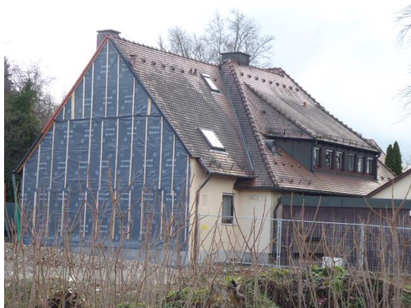
Abb. 9: Ostseite des Gebäudes Gräterweg 12/1 nach Abbruch des Gebäudeteils Gräterweg 12.
