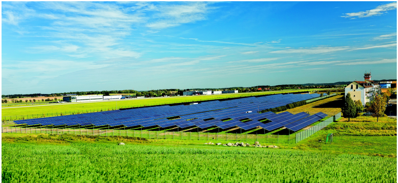
Fotovoltaikanlage im Solpark in Schwäbisch Hall-Hessental
