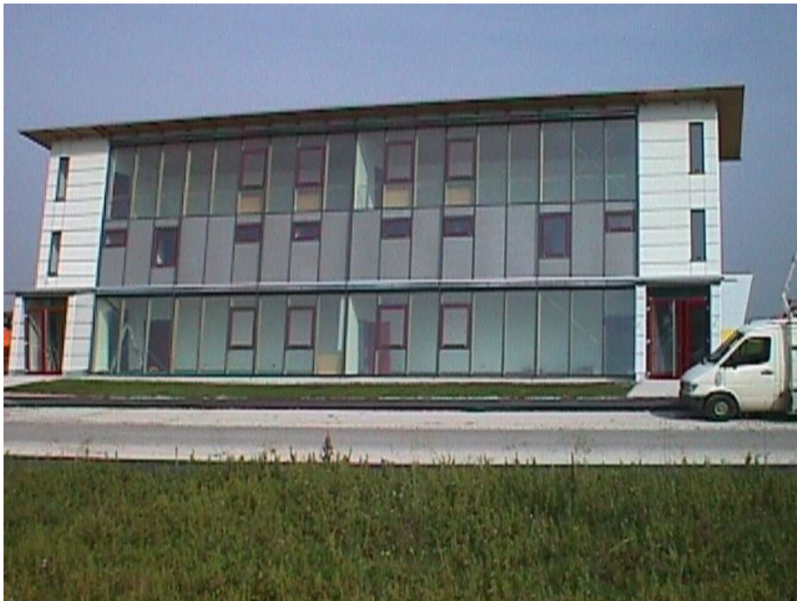
Gewerbehalle in der Geschwister-Scholl-Straße 83, Solpark, in Schwäbisch Hall-Hessental.
