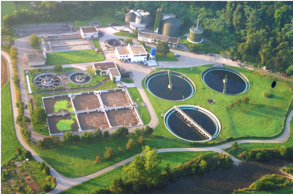
Blick auf die Kläranlage „Vogelholz“
