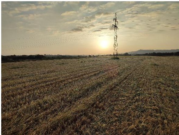
Abb. 5: Stromversorgungsmast auf der Fläche
