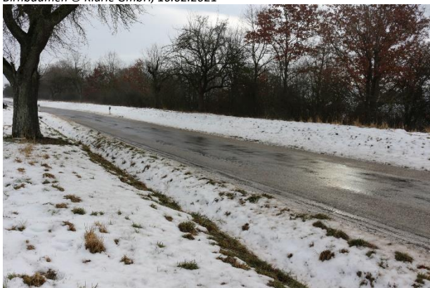
3) Blick auf K 2602 mit Entwässerungsgraben © Klärle GmbH, 16.02.2021
