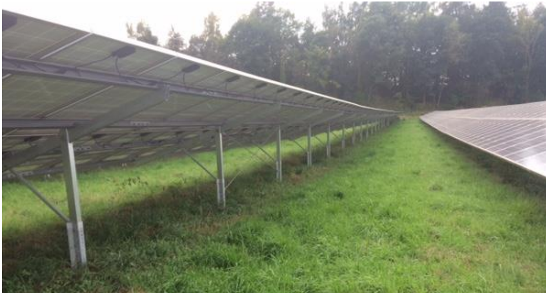
Beispiel für bodenschonend aufgestellte Fotovoltaikmodule
