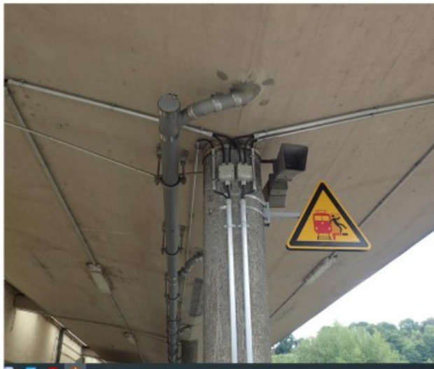
Abbildung 8: Ansicht Dachuntersicht mit Entwässerungsleitung
