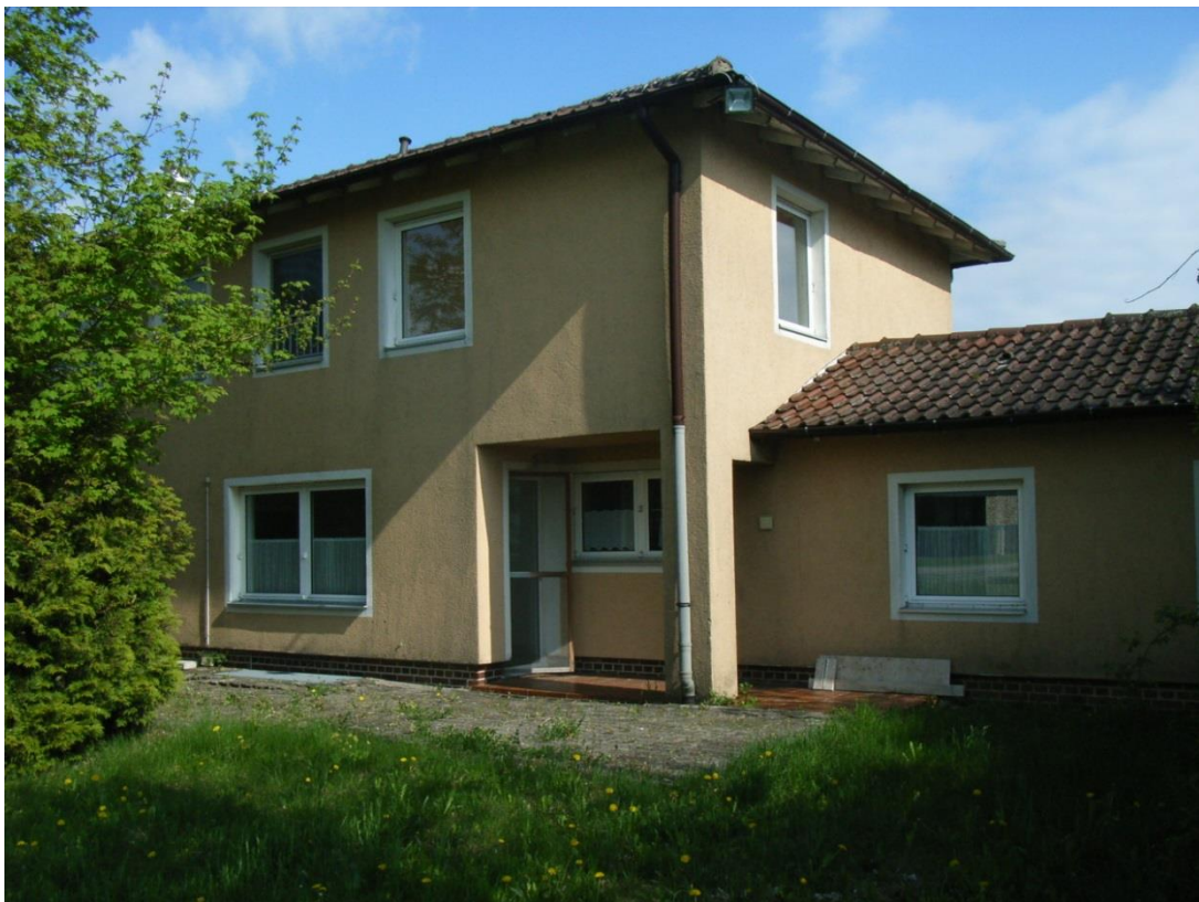
Abb. 8: Gebäude und Dachbereiche Stauffenbergstraße 26 (s. Biotop-Nr. 7).
