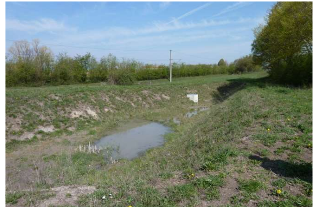
nördlich anschließende Wiese mit Regenüberlaufbecken
