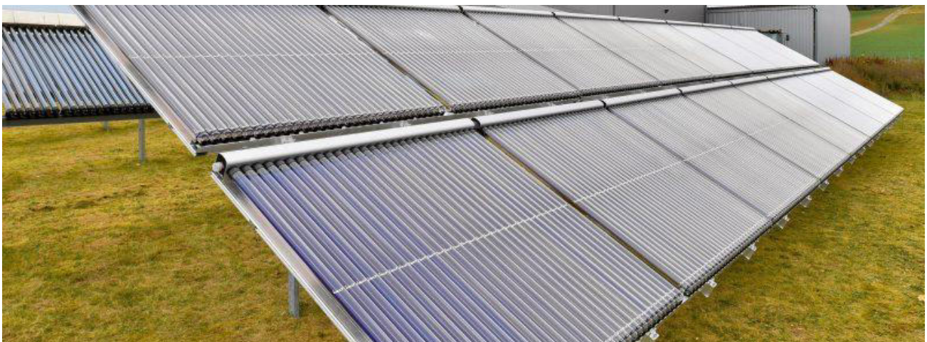
Bild 3.2.2 Solarthermie Röhrenkollektoren (Quelle: Viessmann Werke)
