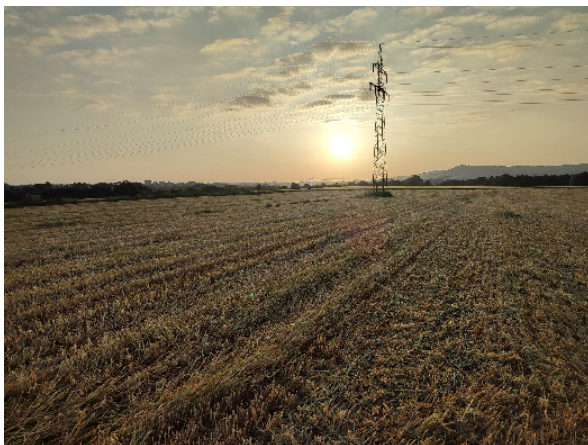
Abb. 5: Stromversorgungsmast auf Fläche
