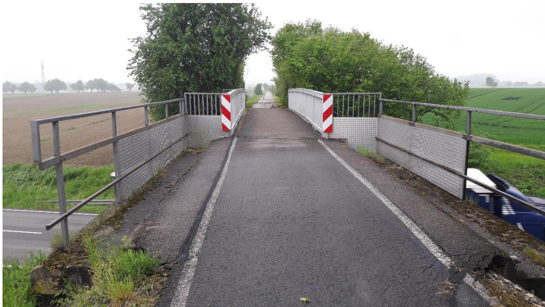
Abbildung 36: Blick auf die alte Trasse und das Brückenbauwerk, Blickrichtung nach Waldenburg
