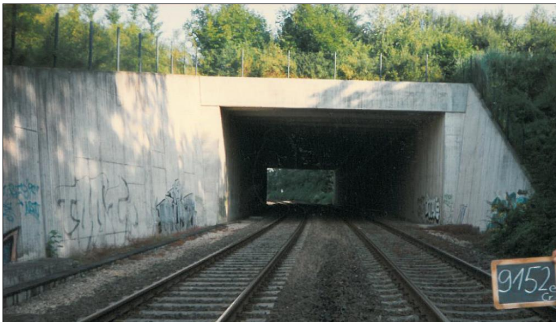
Abbildung 7: Straßenüberführung K 2576 (km 69,4), lichte Höhe > 6 m (Quelle DB 1996)
