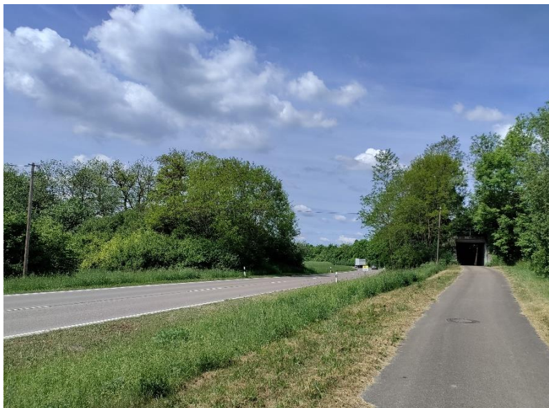
Abbildung 25: Blick auf Querung der Bühlertalstraße (L1060)
