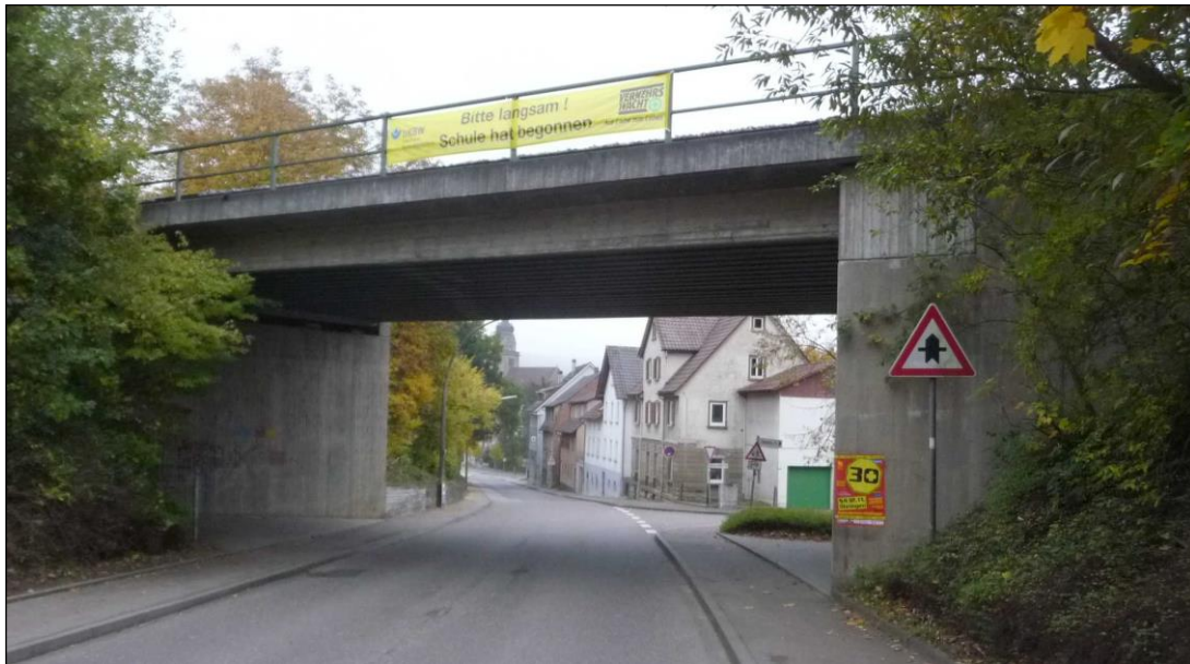
Abbildung 10: Blick von Norden auf die Eisenbahnüberführung in Neuenstein
