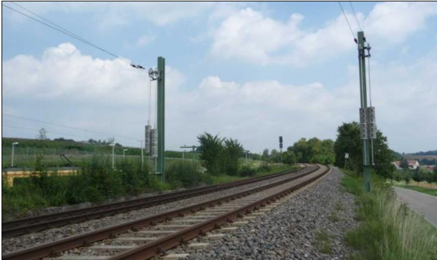
Abbildung 3: Anfang Elektrifizierung in Öhringen-Cappel bei km 89,7
