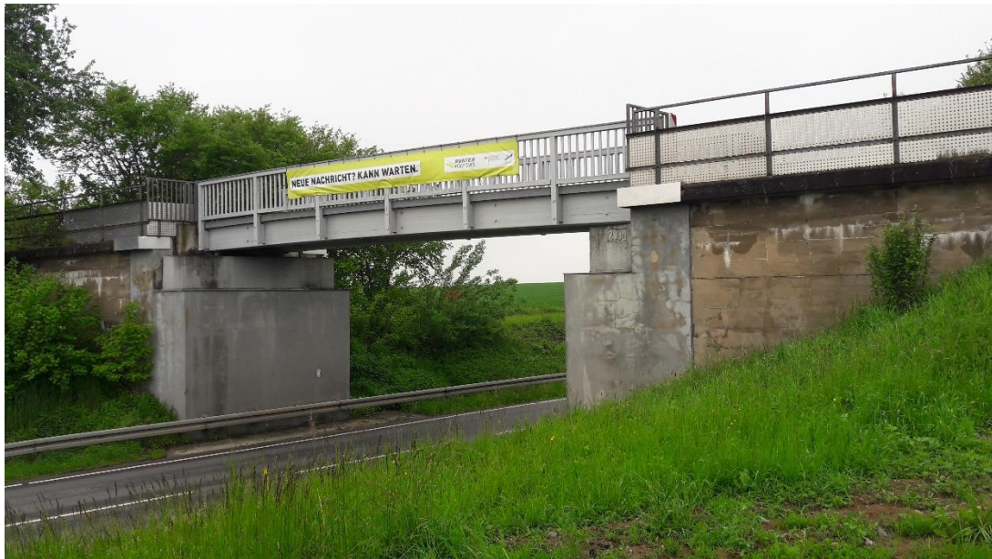
Abbildung 35: Eisenbahnüberführung km 1,95, Blick von Böschung Straße auf die Brücke
