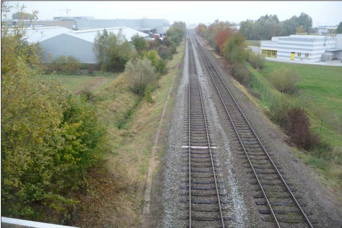
Abbildung 17: Blick von Straßenüberführung Max-Eyth-Straße (km 78,3) in Richtung Heilbronn
