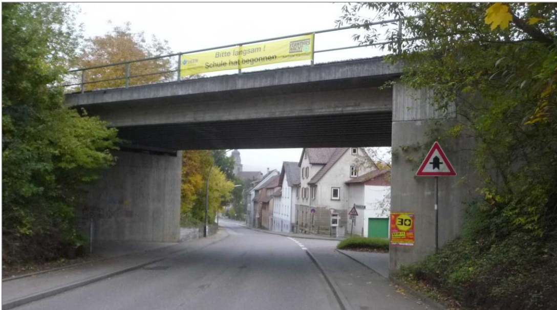
Abbildung 14: Blick stadteinwärts bei der EÜ über Friedrichsruher Straße (km 85,6)
