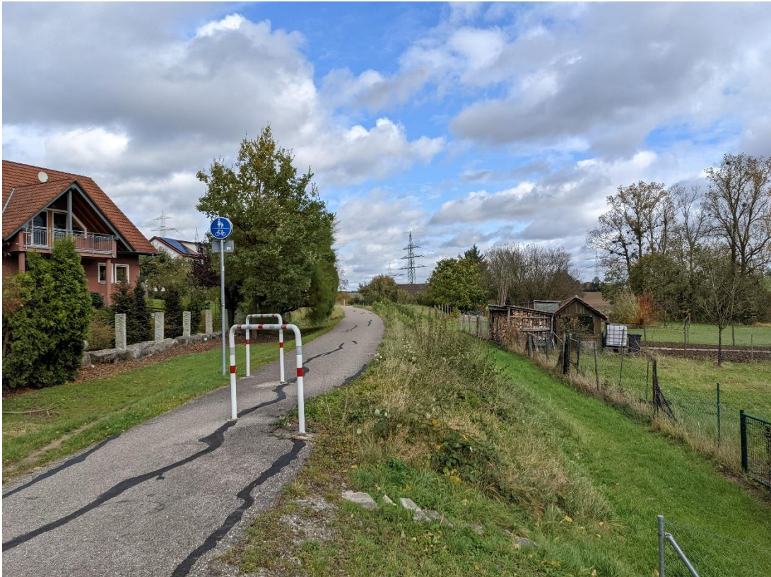
Abbildung 28: Historische Bahntrasse - mit Rad- und Gehweg überbaut
