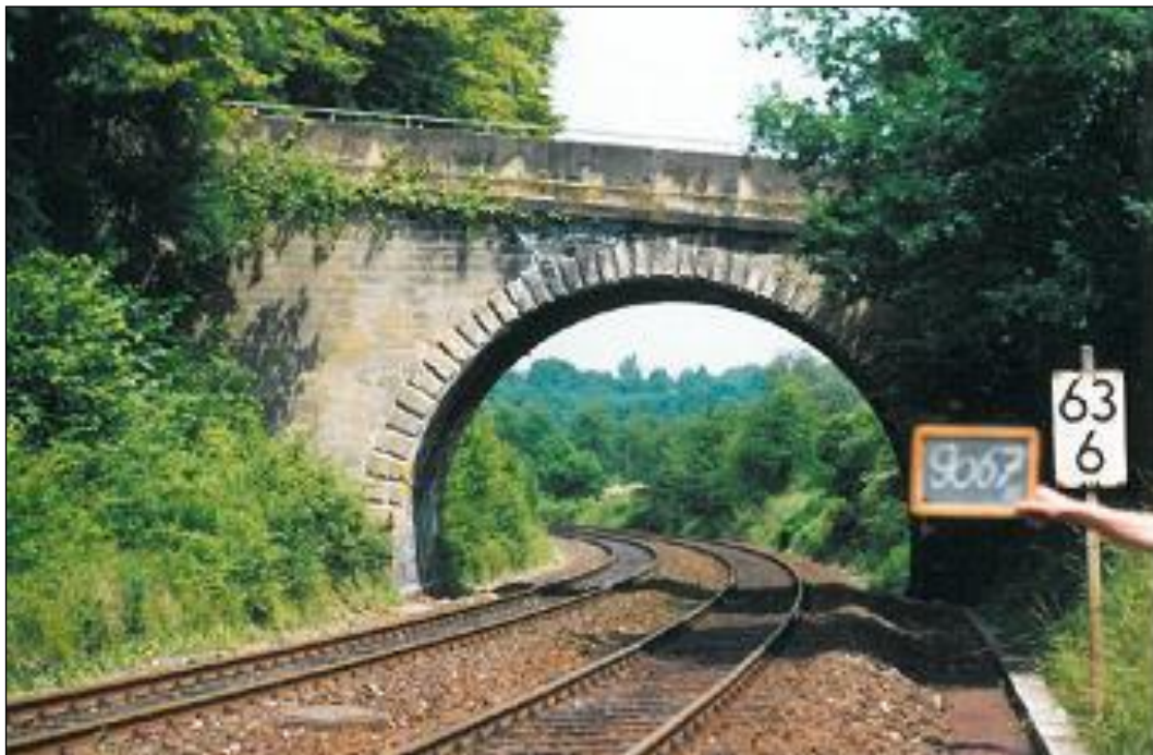
Abbildung 5: Wegüberführung Hagenbacher Steige bei km 63,6 (Quelle DB)
