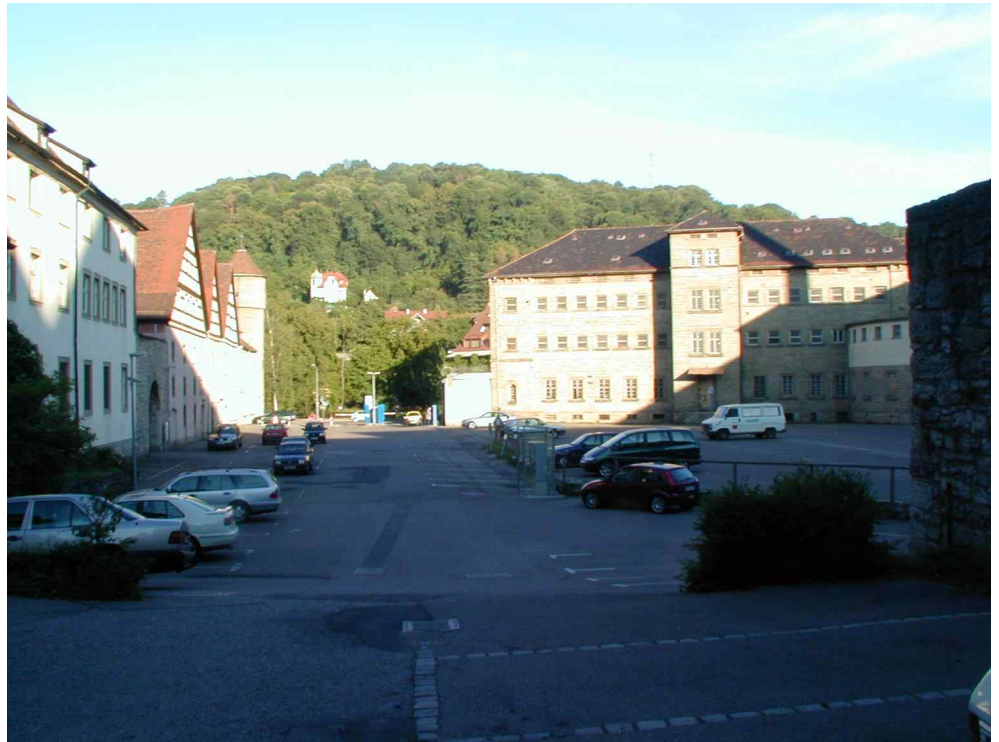
Froschgraben vor der Sanierung
