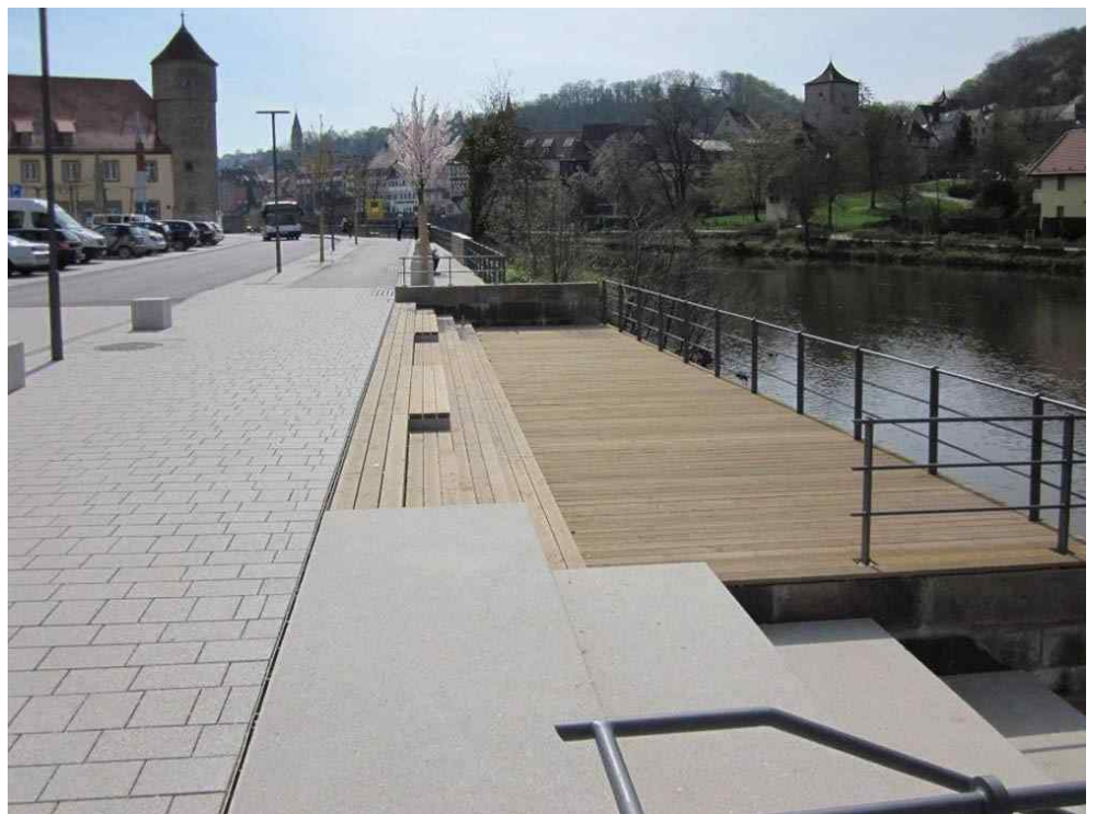
Kocherpromenade nach der Sanierung
