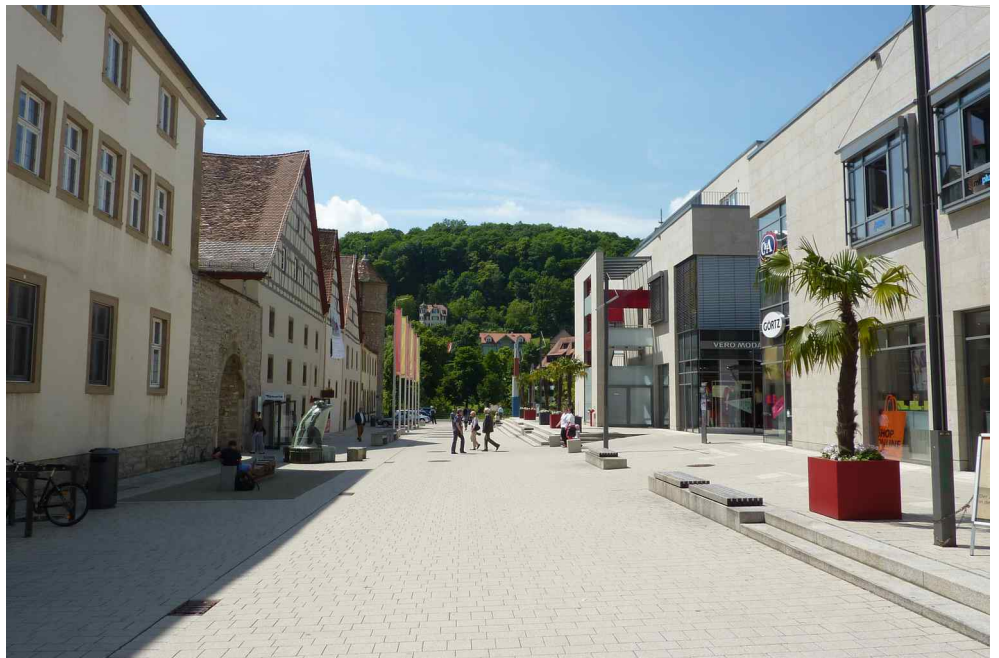
Froschgraben nach der Sanierung – rechts Neubauten Kocherquartier
