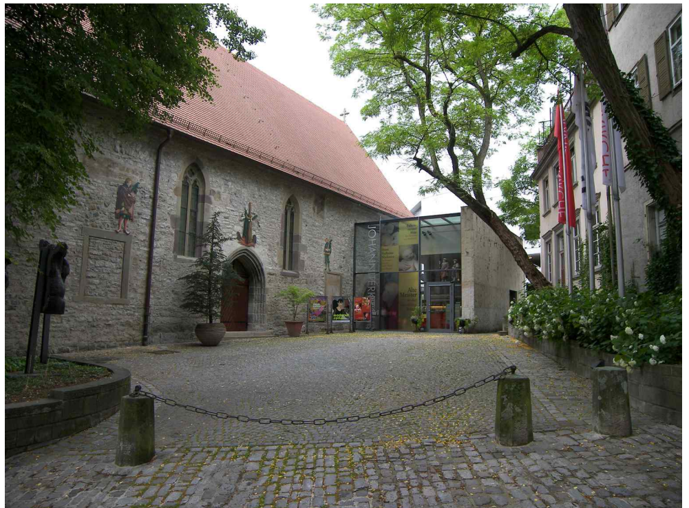
Johanniterkirche (Museumsräume) vor und nach der Sanierung
