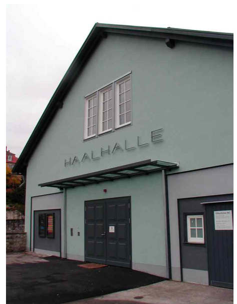
Haalhalle vor und nach der Sanierung
