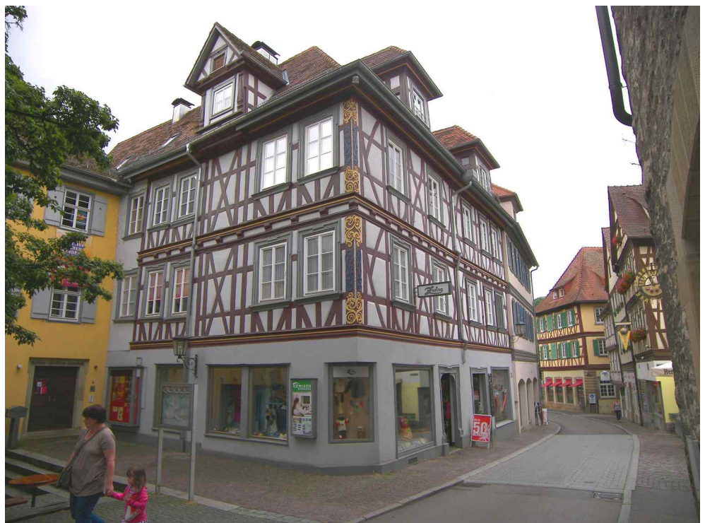
Haalstraße private Gebäude vor und nach der Sanierung
