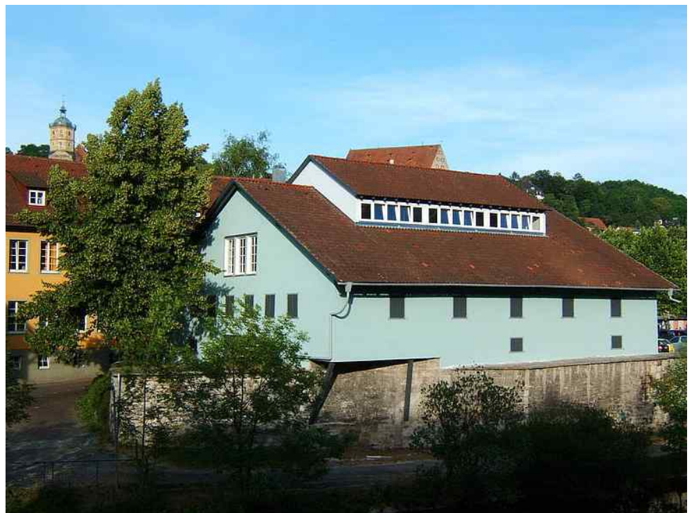
Haalhalle vor und nach der Sanierung
