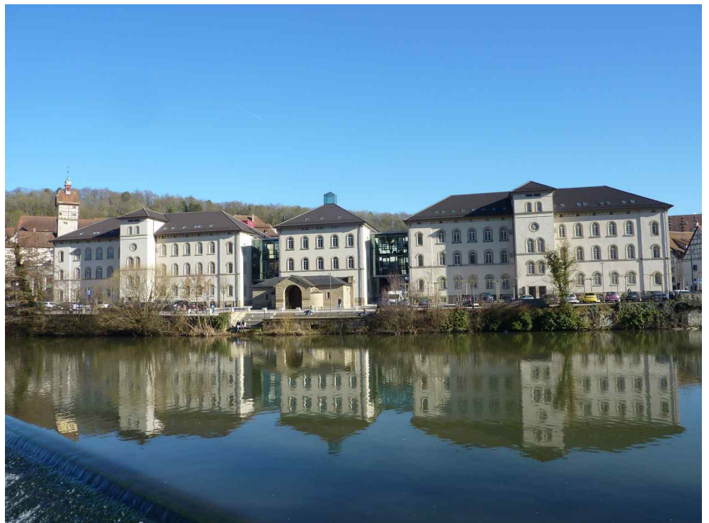
Gebäude der ehemaligen Justizvollzugsanstalt nach der Sanierung Heute: Haus der Bildung
