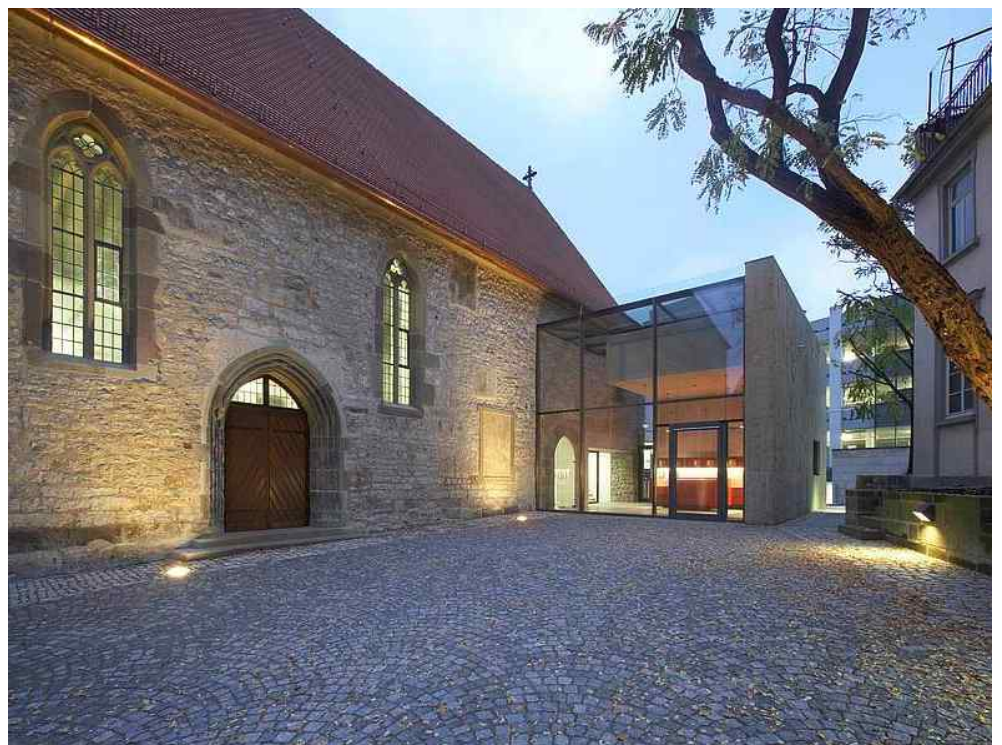
Johanniterkirche (Museumsräume) vor und nach der Sanierung
