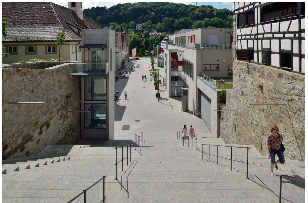
Froschgraben nach der Sanierung
