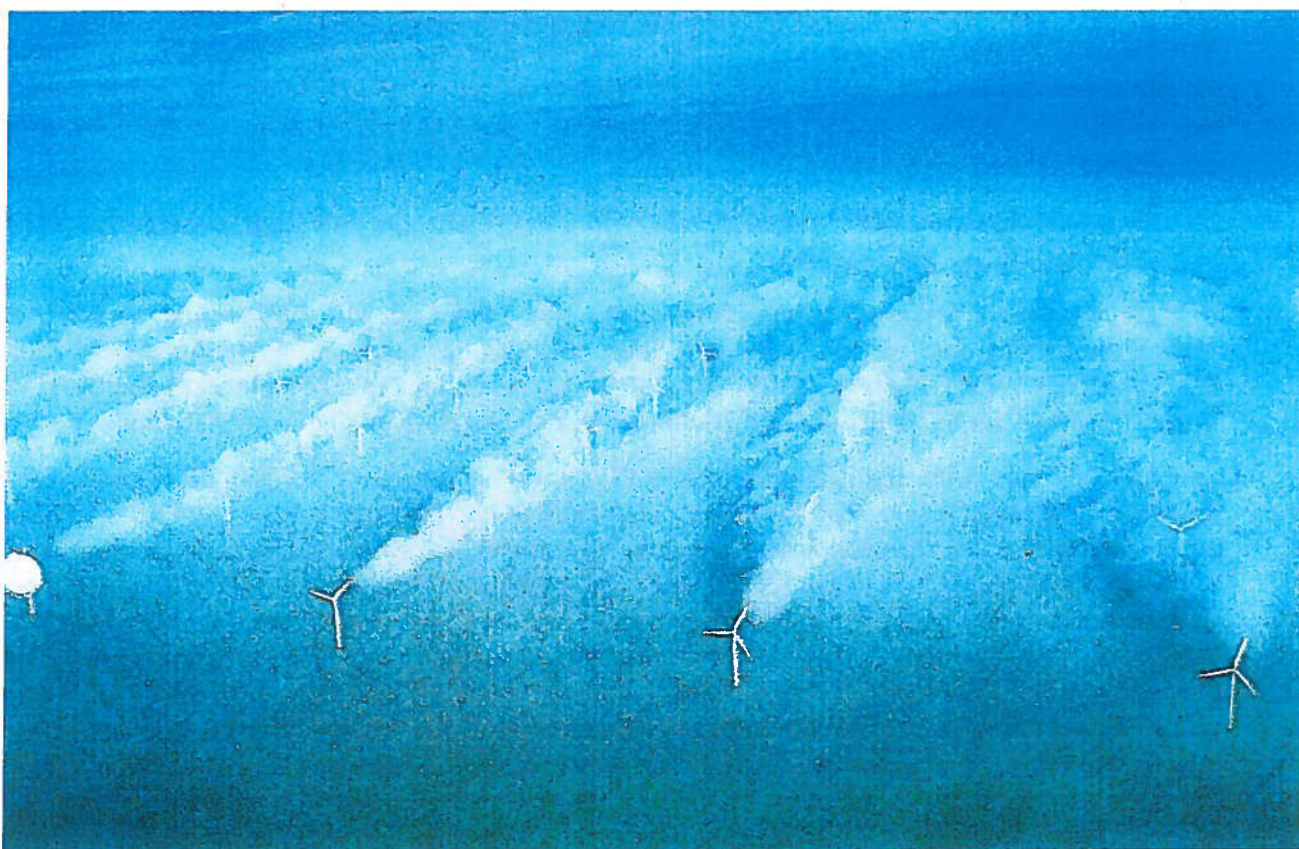
Wie eine Rauchfahne: In Meereswindparks (hier: Horns Rev) verläuft die so genannte Nachlaufströmung, also der von Turbinen abgebremste und verwirbelte Luftstrom, in langen, schmalen Bahnen.
