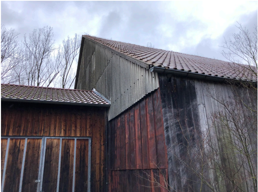
Abb. 8: Westliche Giebelseite der Scheune mit Wellblechverschalung
