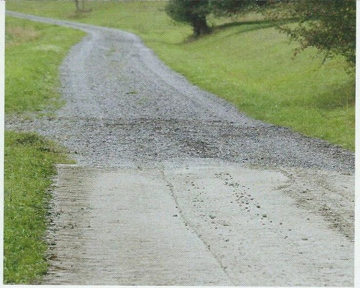
Ein deutlicher Unterschied ist zu erkennen: Der Weg vor (nach Auftrag von einzuarbeitendem Schotter) und nach der Bearbeitung.
