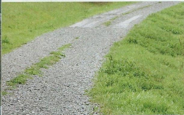
Ist das Verschleißmaterial verbraucht oder sind die Löcher zu tief, muss Schotter aufgetragen werden.
