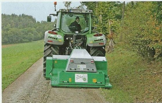
Die zweite Überfahrt dient der Rückverfestigung. Zweigeteilte Rüttelplatten werden dazu eingesetzt.
