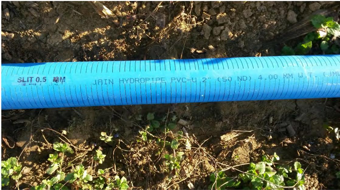
Foto Nr. 55: SCH/GWM11 - Pegelmaterial aus PVC-U2“ - Rohr
