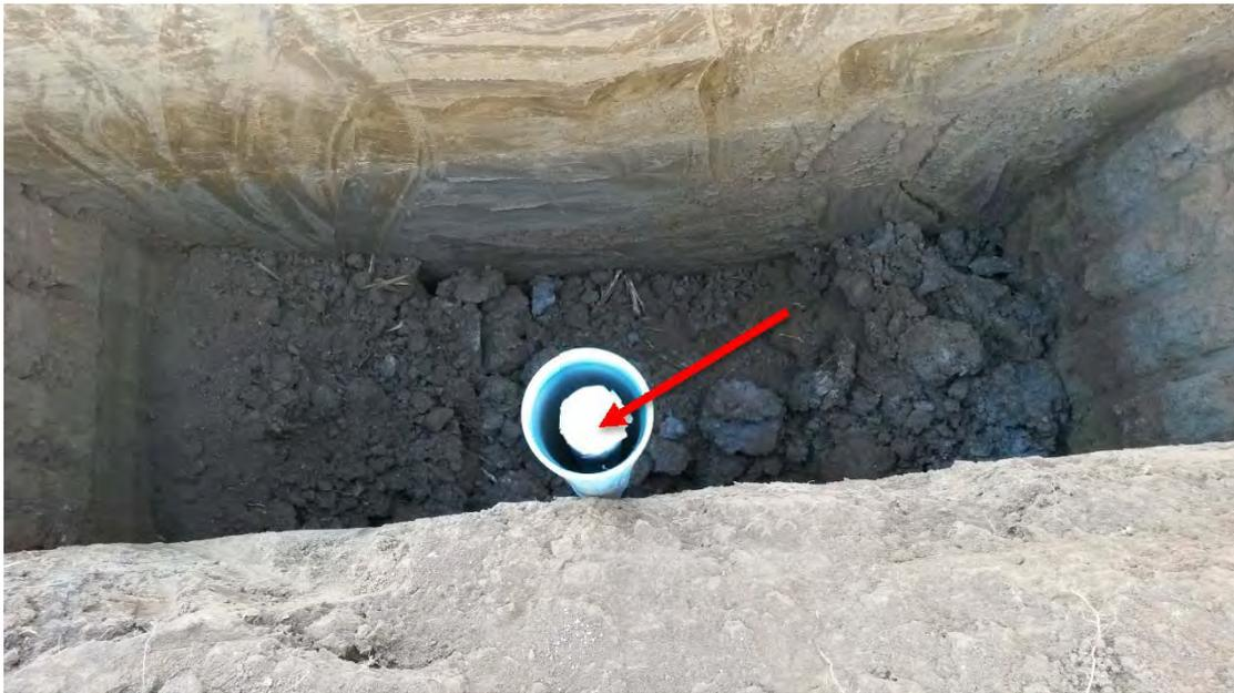
Foto Nr.54: temp. Grundwasserpegel SCH/GWM11 - Pegeleinbau
