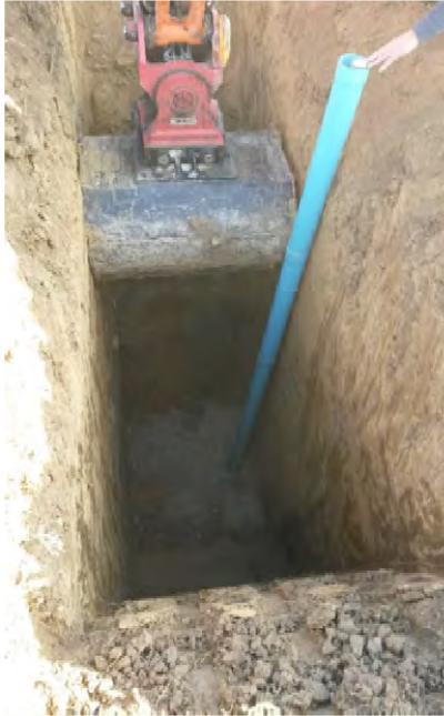
Foto Nr. 53: Baggerschurf SCH11 - Einbau temp. GW-Pegel, DN 50
