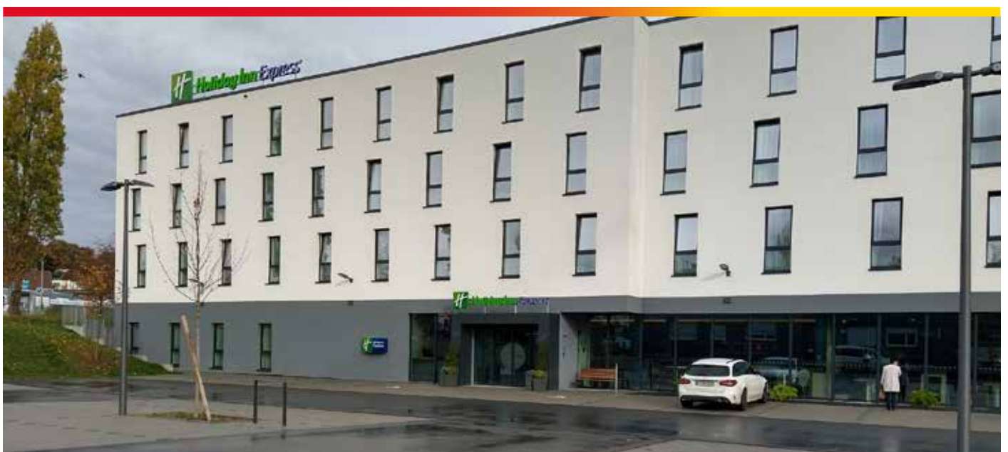
Im Hotel Holiday-Inn-Express in Sindelfingen koppelt enisyst die Raumregelung an das Buchungssystem
