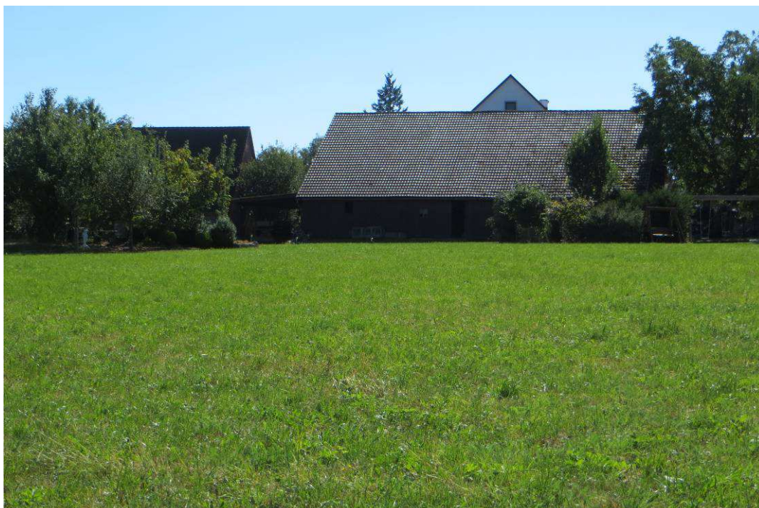
Abb. 6: Intensivwiese im Norden der Flächen, im Hintergrund umzubauende Scheune
